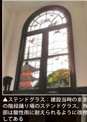
▲スタンドグラス：建設当時のままの階段踊り場のスタンドグラス、外部は断熱性に耐えられるように改修してある
