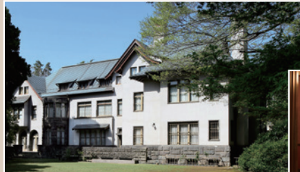
和敬塾本館 外観
