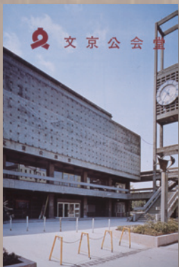
正面玄関 (文京公会堂パンフレットより) 春日通りに面した正面玄関。 1957年(昭和32年)12月27日竣工 写真提供:文京ふるさと歴史館
